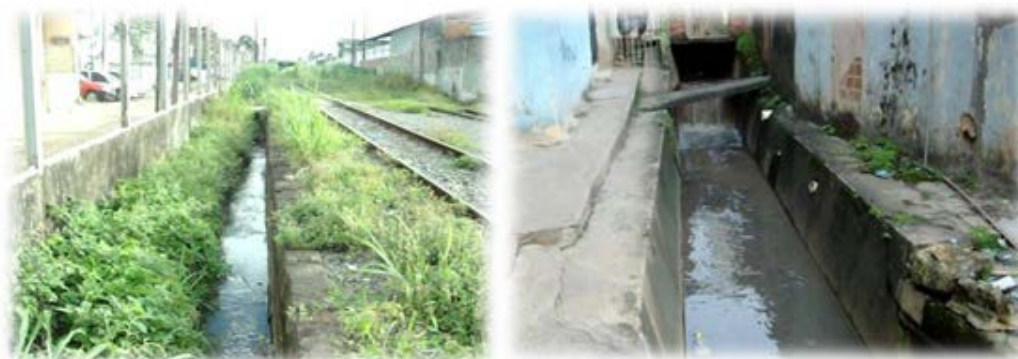
Figura 12: Rede de Macrodrenagem que percorre toda a rua
